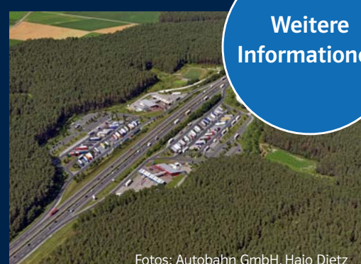
Fotos: Autobahn GmbH, Hajo Dietz
